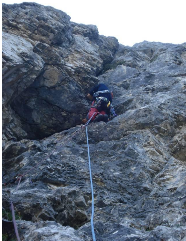
Lavoro di protezione
