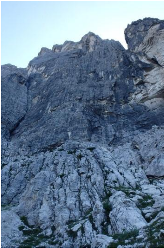
Sotto la parete W della II a Torre del Camp
